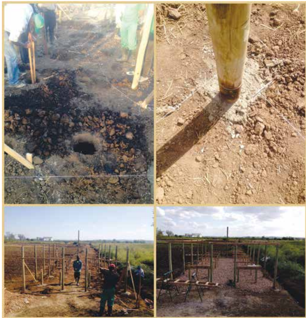
Figura 9. Instalação e esquadramento das estruturas da estufa.
