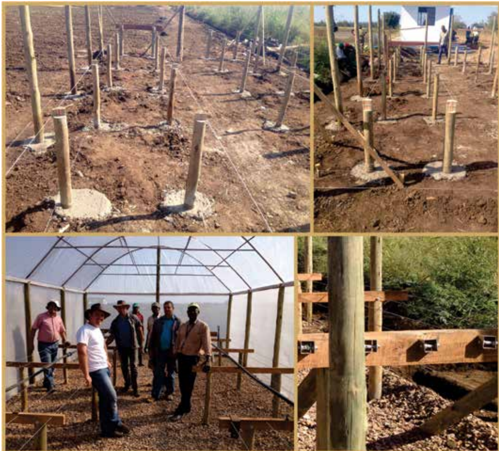
Figura 11. Detalhes da colocação dos arcos de ferro, plástico da cobertura, tela anti-afídeo, porta e colocação de brita no piso da estufa.
